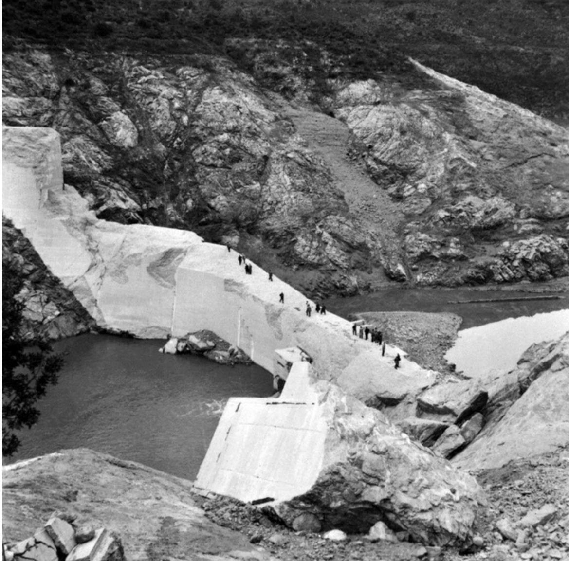
Barrage de Malpasset après sa rupture accidentelle (1959)
